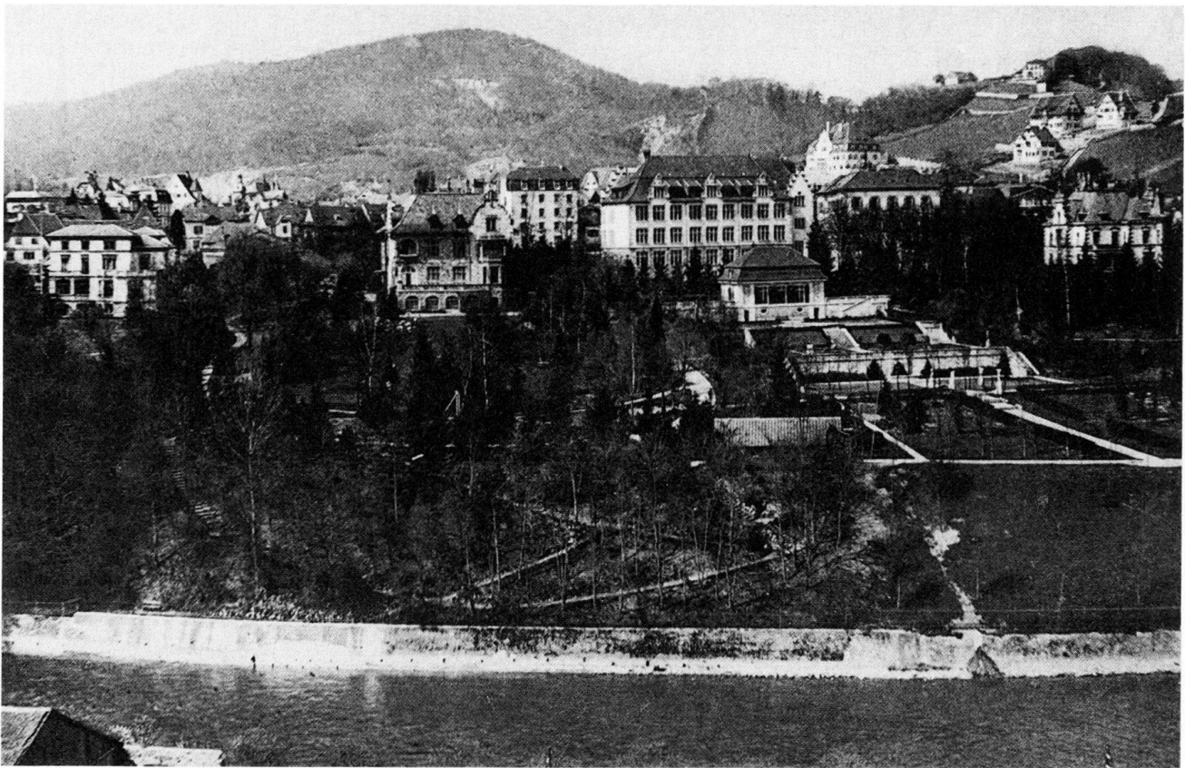
Abb. 44 Baden. Villenzone am Ländliweg, am Steilhang über der Limmat. Rechts aussen Villa Tannegg, erbaut um 1890 von Kaspar Joseph Jeuch für dessen Sohn Karl Robert Jeuch. In der Mitte das Schulhaus Ländli, erbaut 1902–1903 von Dorer & Fuchsli, davor der 1908–1909 für Walter Boveri angelegte Barockgarten, links davon die 1895–1897 von Curjel & Moser erbaute Villa; über dem Schulhaus die 1904–1905 von Curjel & Moser für Boveris Schwager Conrad Baumann erbaute Villa Burghalde an der Mellingerstrasse. Links aussen die 1896 von Dorer & Fuchsli für Fritz Funk, administrativer Leiter der Firma Brown Boveri & Cie, erbaute Villa. Photographie um 1915.
