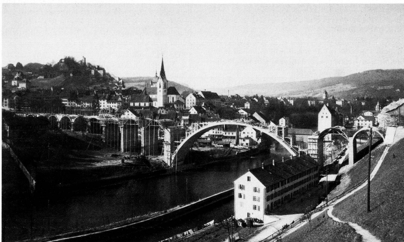
Abb. 8 Baden. Die 1924–1926 als Eisenbetonkonstruktion nach Plänen von Ingenieur Jakob Bolliger (Zürich) erbaute Hochbrücke veränderte entscheidend das mittelalterliche Stadtbild.
