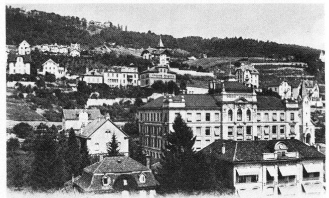
Abb. 20 Biel. Das Technikum, erbaut 1897–1900.
