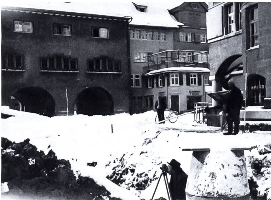
Bau der neuen Kantleigebäude, 1954–1956. (Abb. 14–17)
