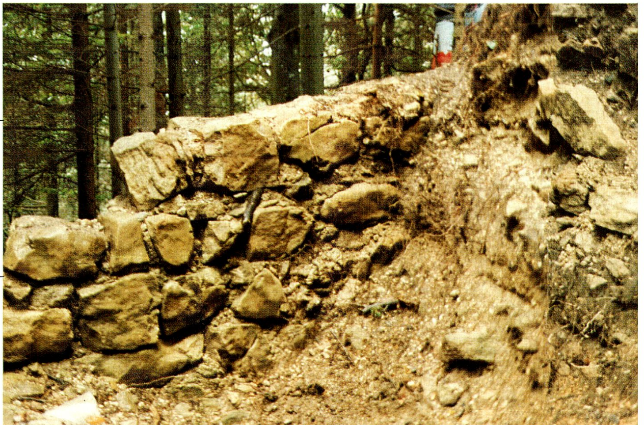
SO-Mauer Inneres Mauerhaupt; Brandrötung des inneren Mauerhauptes
