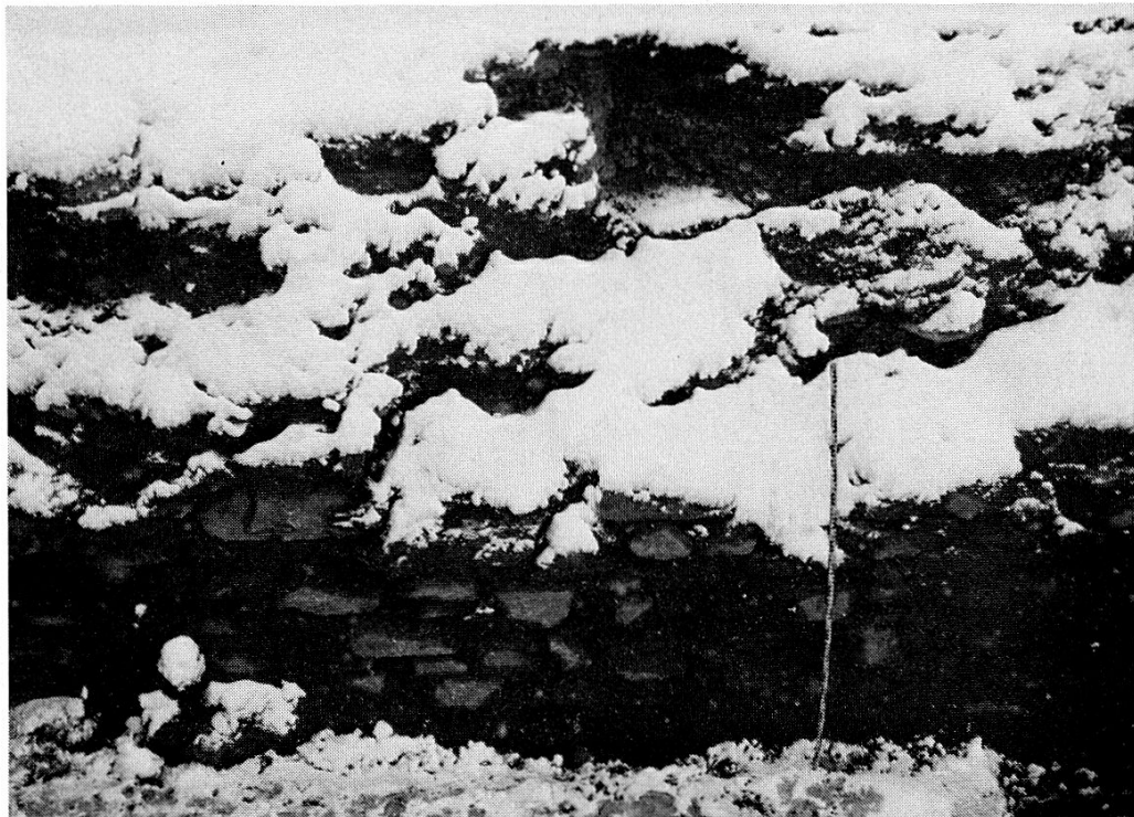
Mauer im Kanalisationsgraben südlich der Dorfkirche
