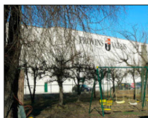
Standort Sitten: Hier wird ausgebaut.
