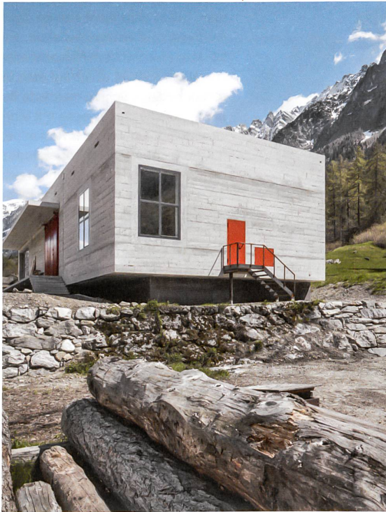
Ein frecher Industriebau im Gewerbestreifen von Stampa im Bergell.
