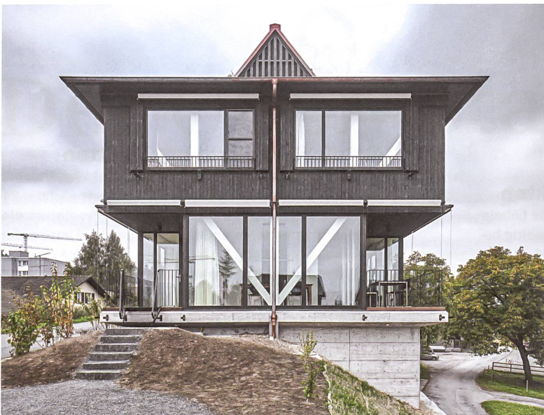
Massiver Sockel, gläsernes Hochparterre, hölzernes Schlafgeschoss: Zweifamilienhaus in Ebikon.
