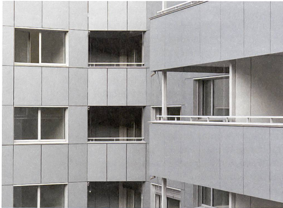
Matt und leicht durchscheinend: Den Glasplatten sieht man es nicht an, dass sie Strom erzeugen.
