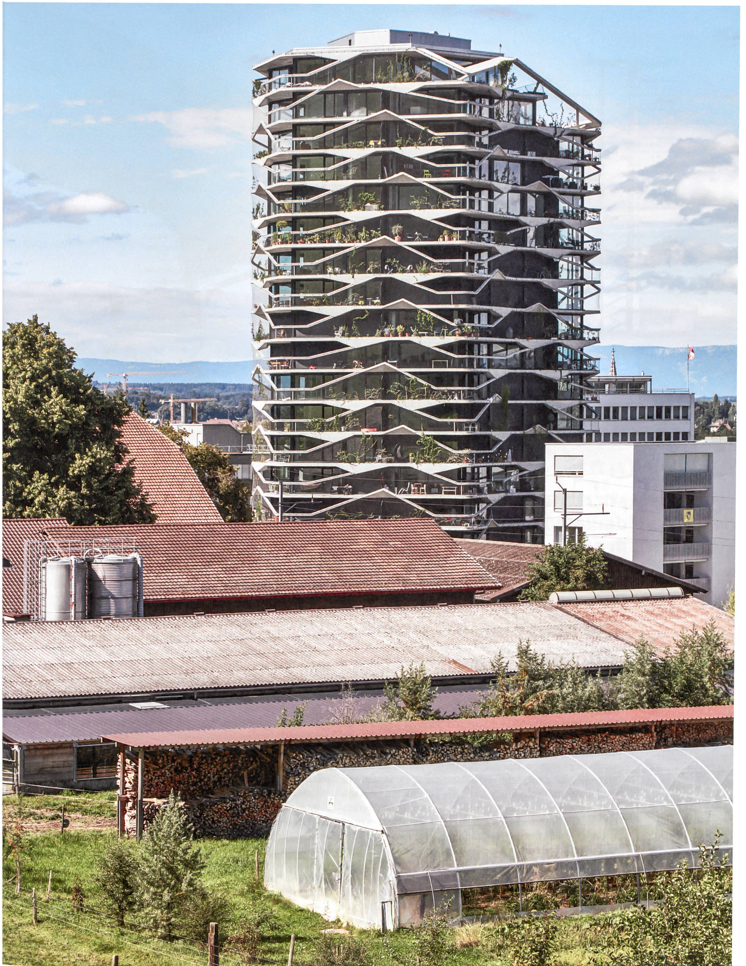
Hinter dem Hof der Stiftung Bächtelen lugt der Green Tower hervor, das erste Hochhaus der Schweiz mit konsequent begrünter Fassade.
