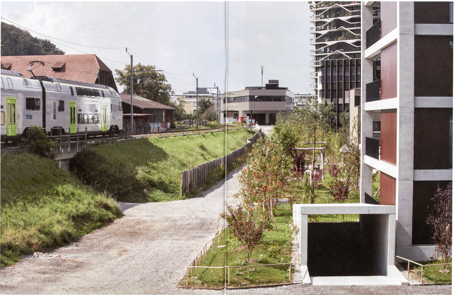
Städtebauliches Schaulaufen in Wabern bei Bern: Neben den Gleisen staffeln sich die unterschiedlichen Gebäudetypen.
