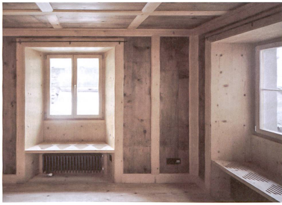
Kleiner Umbau im Bergell: In der Stüa gliedern neue Abdeck- leisten das Täfer.
