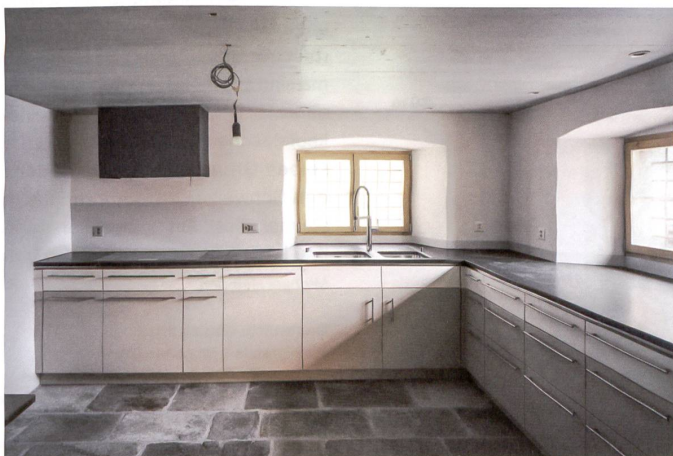
Die zur Cucina lasierte Betondecke steift den Altbau aus und verteilt Leitungen.
