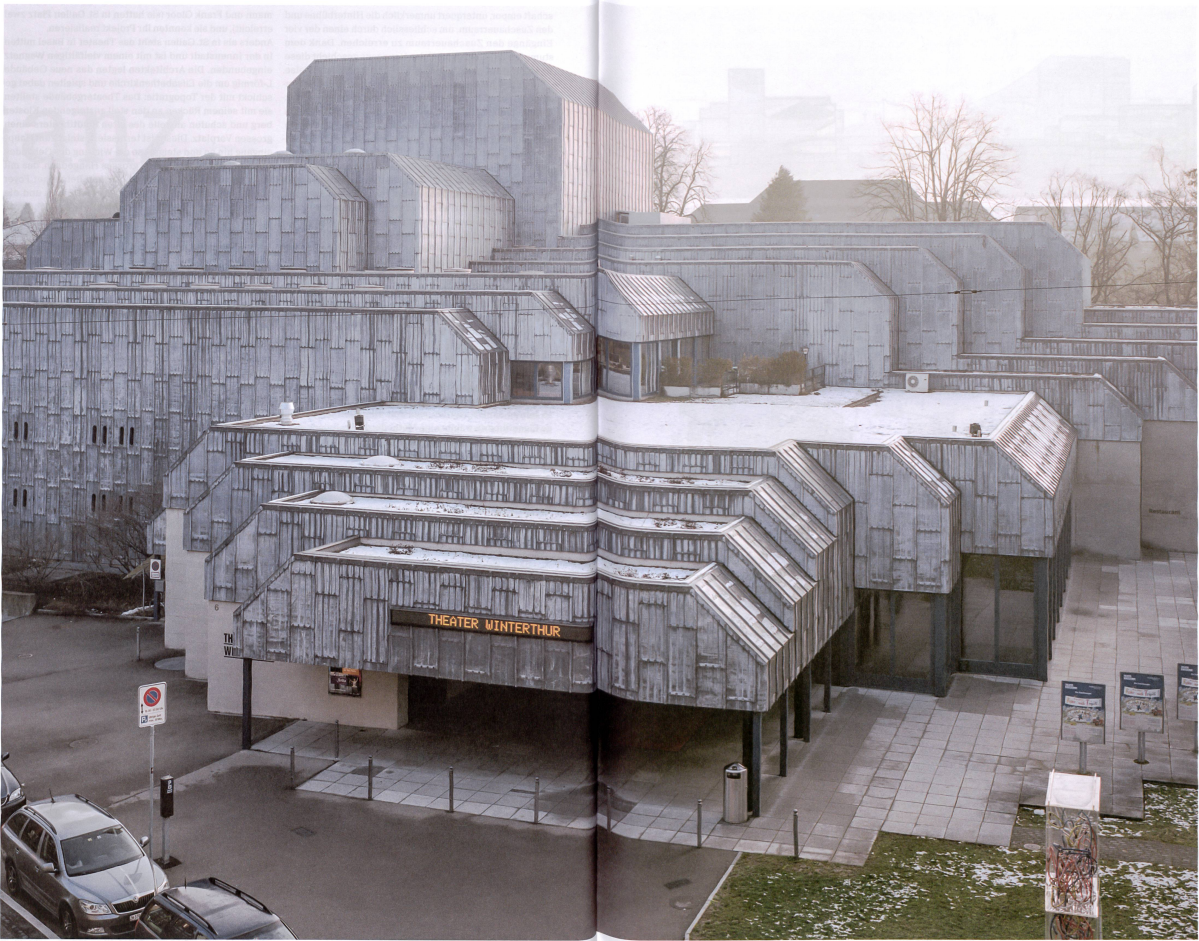
Architekt Frank Kreyenbühl staffelte das Theater Winterthur in Grundriss und Schnitt vielstufig ab und hüllte es in eine dicke Haut aus Blei. Die Leuchtschrift, die diese Haut schmerzlich ver- letzt, ist eine spätere Zutat. Foto: Susanne Heftli
