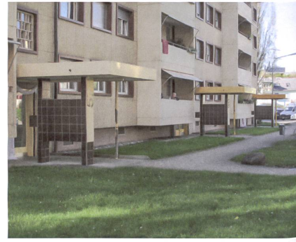
Nüchterne Hauseingänge auf der Strassenseite.
