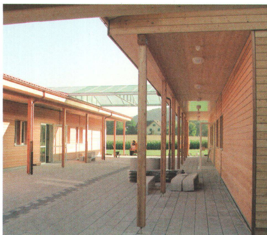
1 Die Erweiterung des Schulhauses Ennetgraben in Affoltern am Albis besteht aus zwei identischen Pavillons.
