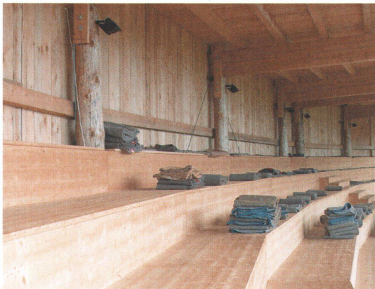
1 Wände, Dach, Böden und Sitzbänke – alles wurde aus einheimischem, vor Ort geschlagenem Holz gefertigt.
