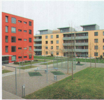
Überbauung Binzhof VI 56
