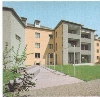
Sanierung MFH Schaffhauserstrasse 60
