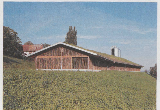
3 Durch Weiterziehen der Wiesenflächen auf die Dachflächen wird das Volumen in die Umgebung integriert, die zwei glänzenden Futtersilos sitzen innerhalb des Kuhstalls, durchstossen jedoch an einer Stelle das Gründach. Foto: Christian Baur
