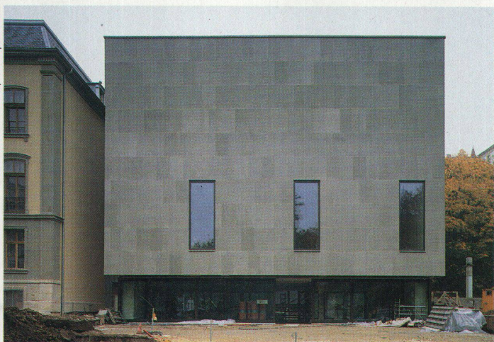
Das renovierte und erweiterte Centre PasquArt in Biel von Diener und Diener
