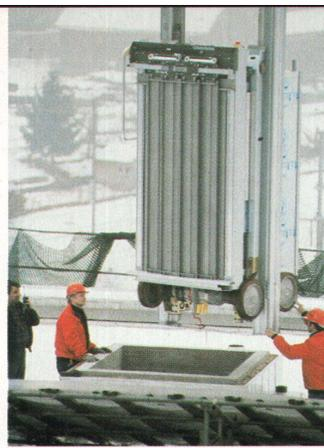
Die Kabine wird samt Tragkonstruktion vom Kran in den Liftschacht versenkt
