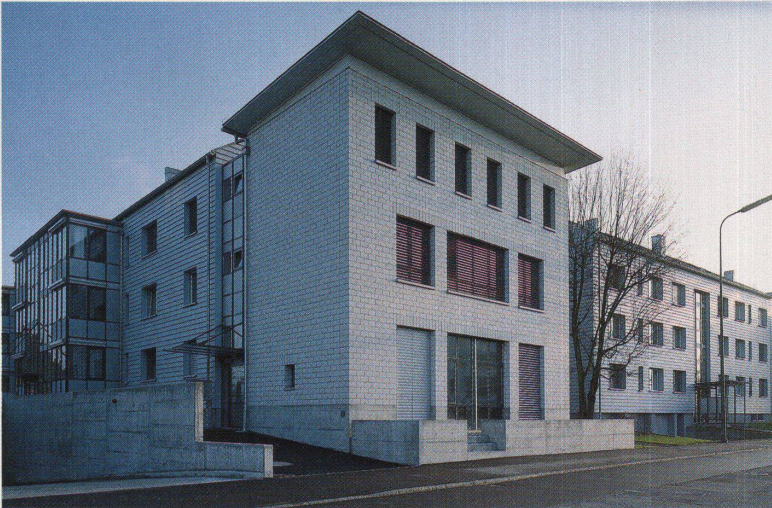
Aarepark Solothurn: ein Demonstrationsobjekt
