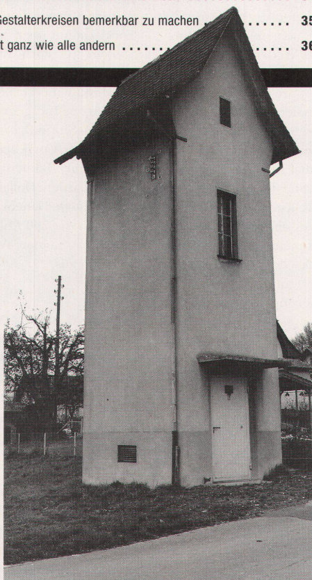
Heute verloren im Land: Transformatorenhäuschen
