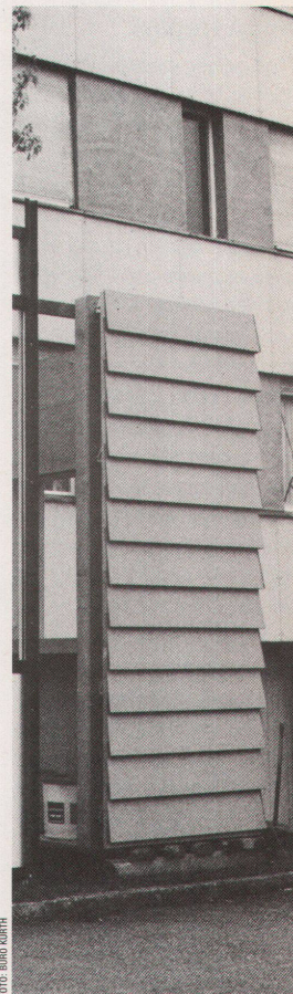
Der sanierungsbedürftige Aarepark (Bild links) erhält auch eine neue Fassade aus Eternit.
