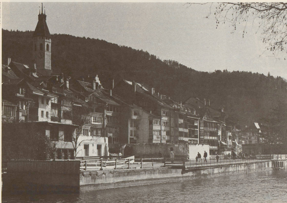
Das Thuner Mühleareal heute: Der mächtige Industriebau ist verschwunden, übrig bleibt das Turbinengehäuse.
