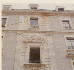
Das sanft renovierte Quartier des Grottes in Genf. Seite 78
