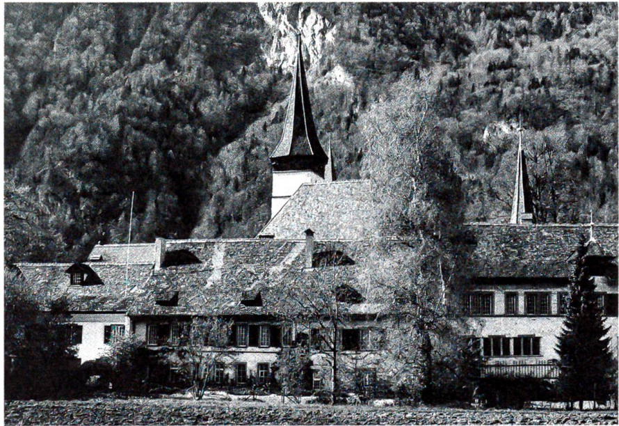
Blick von Süden auf das ehemalige Kloster Interlaken (Foto F. Schobert, Interlaken)
