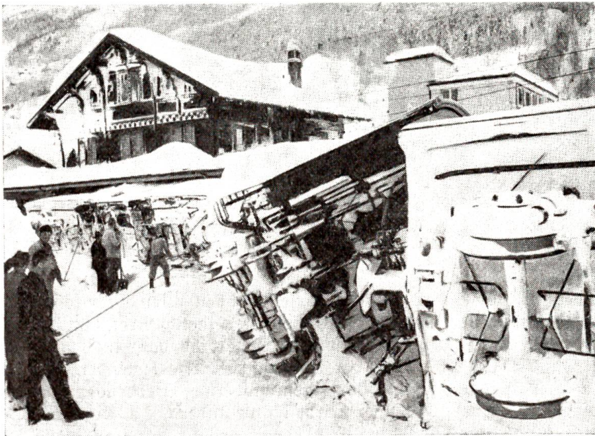
Eine riesige Lawine ging anfangs Januar in der Gegend des Bahnhofs Zermatt nieder. Sechs Eisenbahnwagen wurden vom Luftdruck aus den Schienen gehoben und umgekippt. Zum Glück gab es keine Verletzten
