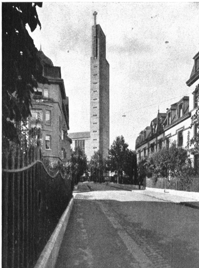
Abb. 10. Die neue St. Antoniuskirche zu Basel. Vom Industrietypus angeregte, mit Vorbehalten anerkennenswerte Leistung modernster Eisenbeton-Architektur. Architekten Dr. K. Moser, Zürich u. G. Doppler & Sohn, Basel. Ansicht von der Wintergasse aus. Photo A. Höllinger, Basel. — Fig. 10. La nouvelle église Saint-Antoine à Bâle. Architectes: MM. le Dr. K. Moser de Zurich et G. Doppler et fils à Bâle. Nous acceptons avec certaines réserves cet exemple intéressant de l'architecture moderne en béton armé. Vue prise de la Wintergasse. Photo A. Höllinger, Bâle.
