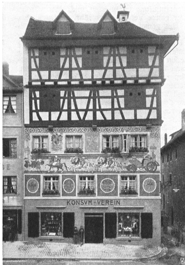
Abb. 22. Gut restaurierte Fassade am Rathausplatz in Steina, Rh. Fresken von August Schmid in Diessenhofen. Aufnahme von C. Koch , Schaffhausen. — Fig. 22. Façade restaurée avec goût d'une maison sur la place de l'Hôtel de ville à Stein s/le Rhin. Les fresques par le peintre August Schmid à Diessenhofen.
