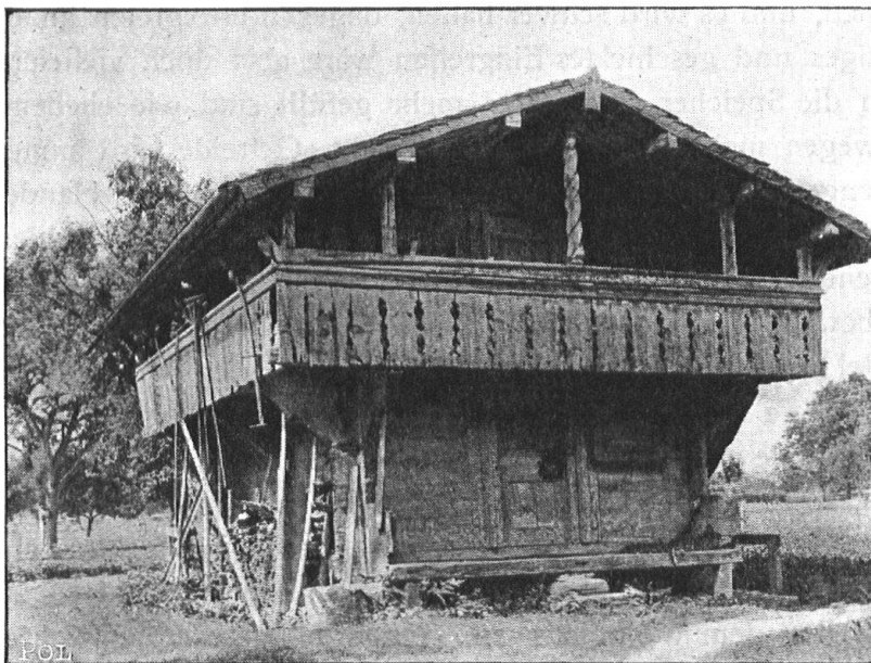
Abb. 3. Speicher in Reutigen. Oberländer Typus mit Flachdach. Fig. 3. Grenier à Reutigen. Type de l'Oberland à toit plat.
