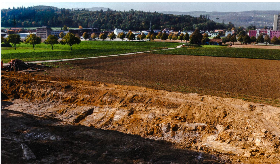
Abb. 34: Windisch-Untere Lätte 2018 (V.018.6). Übersicht von Nordosten auf das Areal der Schiessanlage nach Abbau des Zeigerstandes und Rückbau des Kugelfanges. Im Hintergrund, dies- und jenseits der Baumreihe, verlaufen die beiden Wasserleitungen von Vindonissa .
