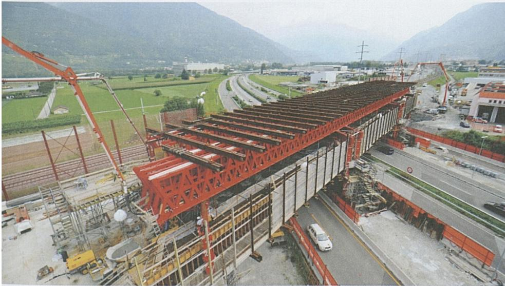
Nodo di Camorino: Die neue Eisenbahnbrücke über die Autobahn A2 wird betoniert.
