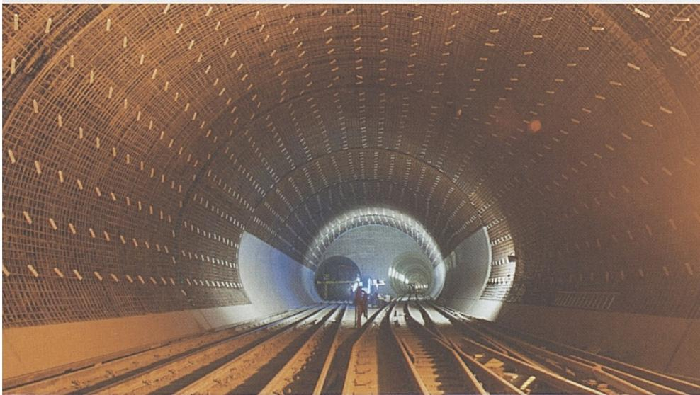
Faido: Armierte Tunnelwechsellaufweitung – bereit für die Betonarbeiten.
