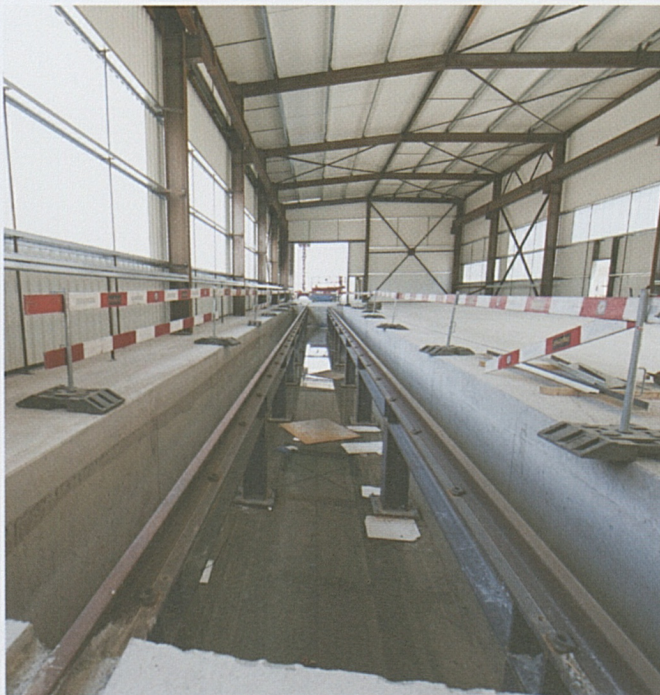
Halle für die Wartung der Züge.
