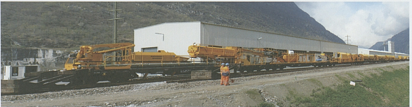
Der 400 Meter lange Betonzug in Biasca kommt im Verlaufe des Jahres in den Kanton Uri.
