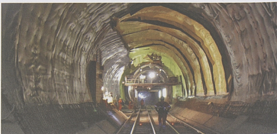
Applicazione isolamento.
