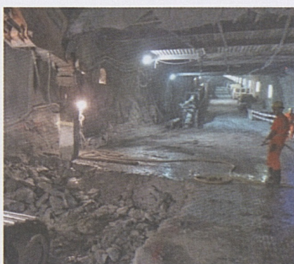
Demolizione della soletta provvisoria nella caverna trasversale.
