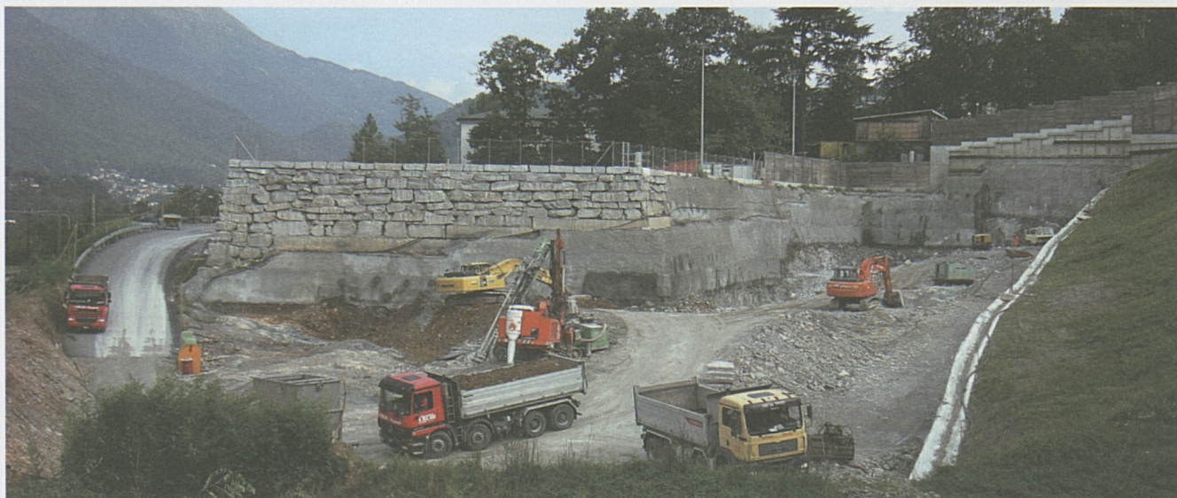
Panoramica della trincea di approccio al portale sud.
