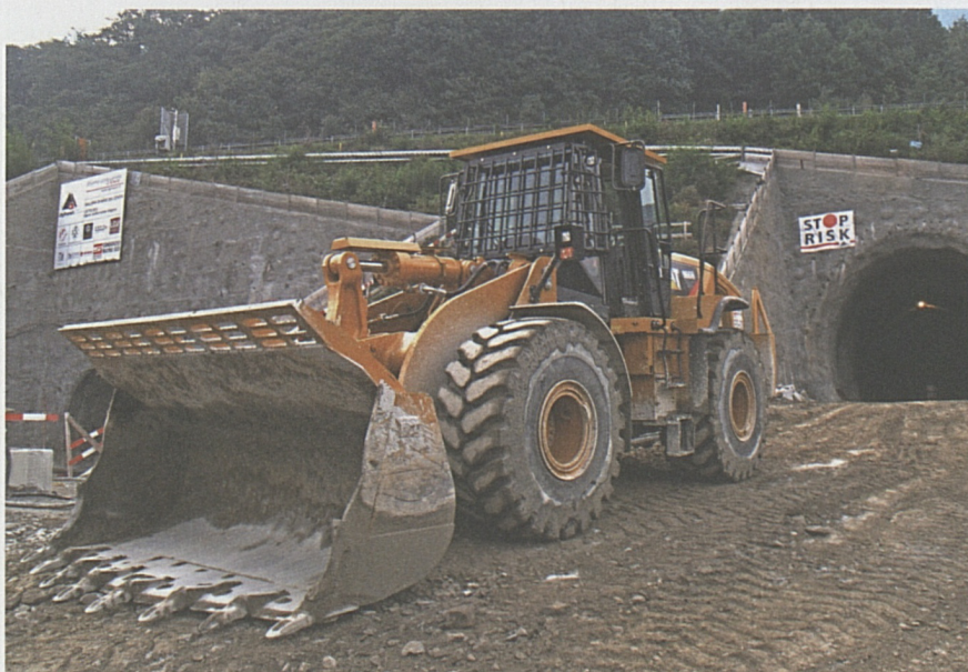
Portale di Vigana: scavo in materiale sciolto in bretella.
