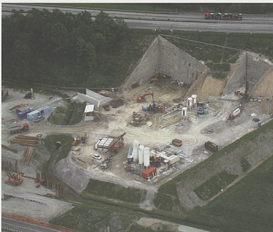
Portale di Vigana: trincee di approccio all'autostrada A2.
