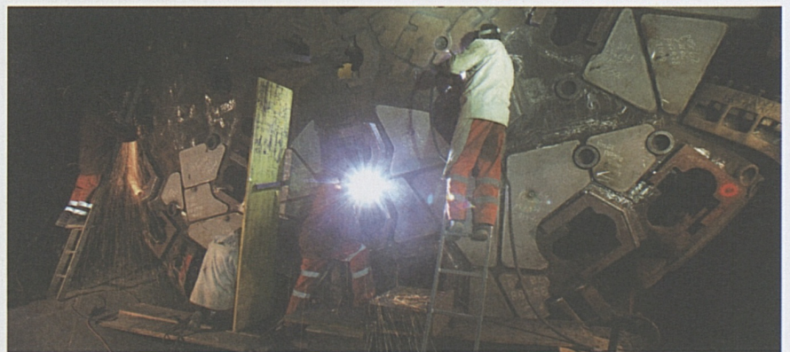
Lavori di revisione alla testa della fresa.
