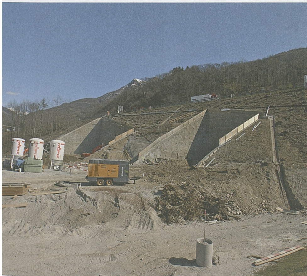
I due portali nord della Galleria di base del Ceneri.
