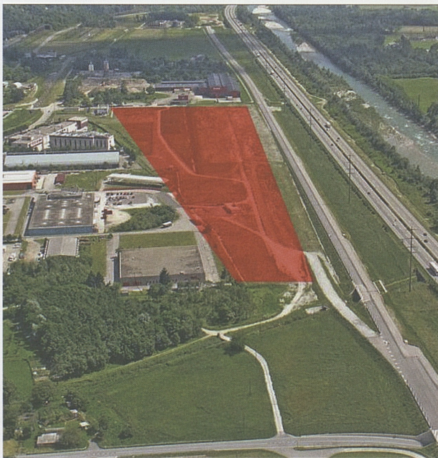
Panoramica delle future installazioni di tecnica ferroviaria
