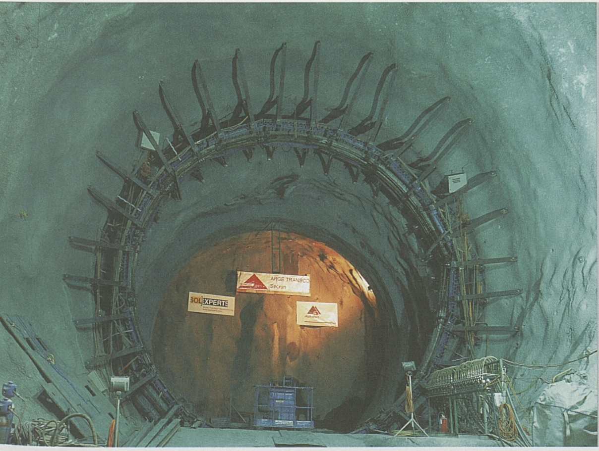
Blick in die riesige Versuchsnische für den Stahlbau im Tavetscher Zwischenmassiv.
