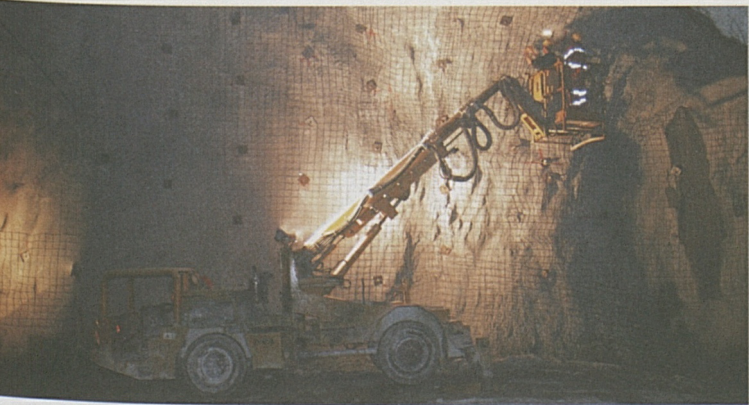
Arbeit in luftiger Höhe tief unter dem Berg Tgom.
