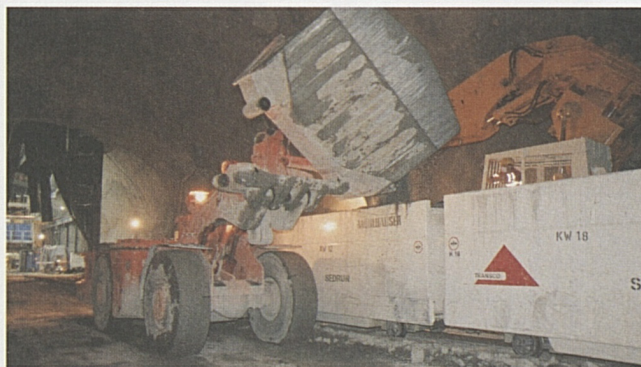
Für den Abtransport des Materials kommen in Sedrun spezielle Förderwagen zum Einsatz.
