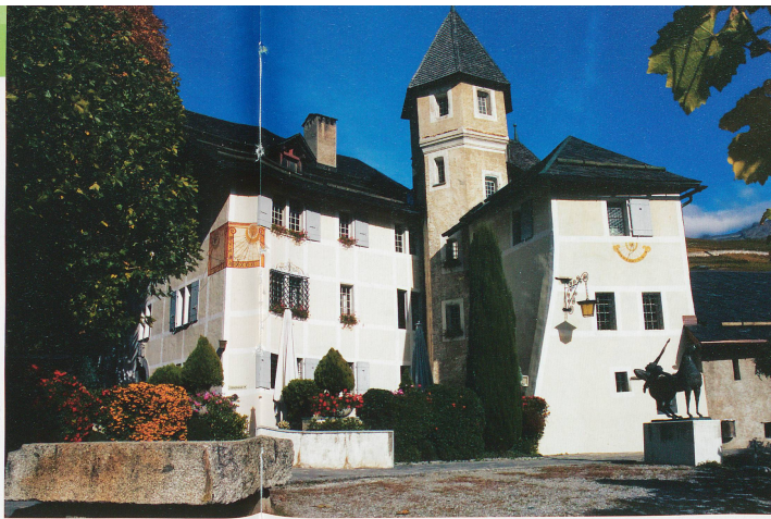
Les premières pierres de ce château sierrois ont été posées au 16 e siècle.
