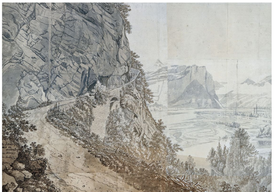
Abb. 4: Jan Hackaerts bekannte Zeichnung der Hohwand ist die älteste bildliche Darstellung der Schollbergstrasse. Sie zeigt exemplarisch die unterschiedlichen Elemente des Ausbaus mit Halbgalerie, Brücke, Stützmauer, Brüstungsmauer oder Flechtzaun, erdiger Fahrbahn im Flachen und Pflasterung auf der Gefällsstrecke (Ausschnitt nach: JAN HACKAERT, Die Schweizer Ansichten, 1653-1656, bearb. und kommentiert von Gustav Solar. Dietikon-Zürich 1981, Tf. 14).
