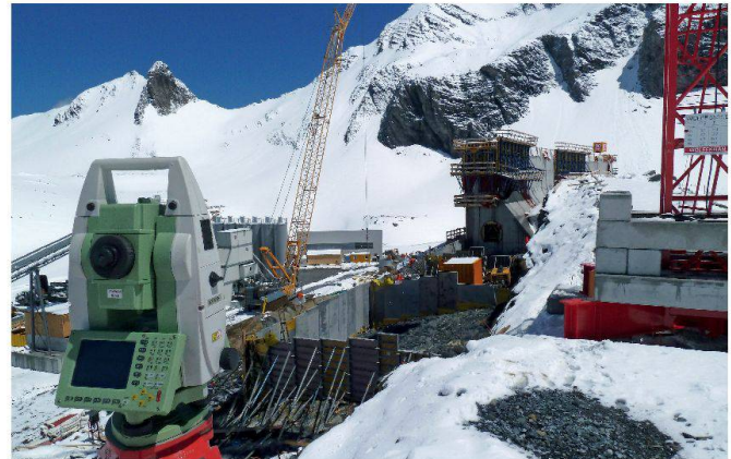
Abb. 5: Schalungskontrolle Staumauer Muttsee.
