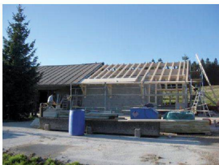
Fig. 5: Construction d'une nouvelle fromagerie d'alpage.
