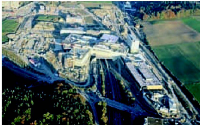
Abb. 1: Die WESTside: die Grossbaustelle.
