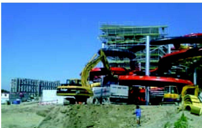
Abb. 7: Geländeabsteckung vor der Wasserrutschbahn.
