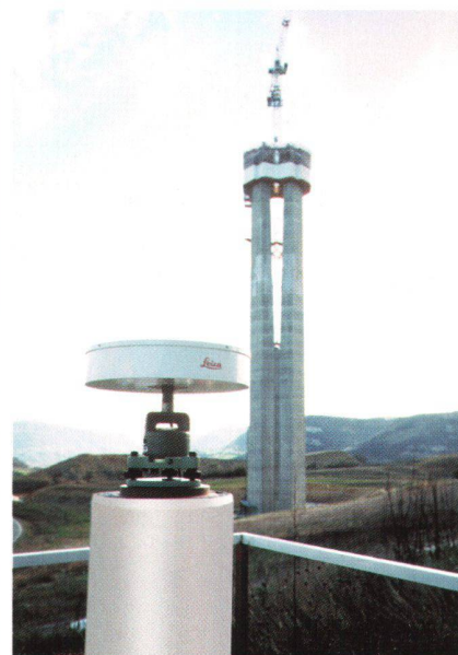
Abb. 2: Die verschiedenen hohen Brückenpfeiler sind in den oberen 90 Metern gabelförmig betoniert. Auf dem linken Bild schiebt sich von der südlichen Rampe bereits die erste Fahrbahn-Profilplatte Richtung Leererüst und Pfeiler P7. Ihre jeweilige Position und die gesamten Betonierarbeiten werden mit Leica GPS-Vermessungssystemen direkt eingemessen. Die vor Baubeginn fest installierte Referenzstation Leica GPS 530 RTK (Bild rechts) sendet für die differenzielle Messung im gesamten Baugelände rund um die Uhr Korrekturdaten aus. Dies ermöglicht es den Baufachleuten, mit ihren mobilen Leica GPS-Systemen die Betonverschalungen millimetergenau einzumessen. Foto: Leica Geosystems.
