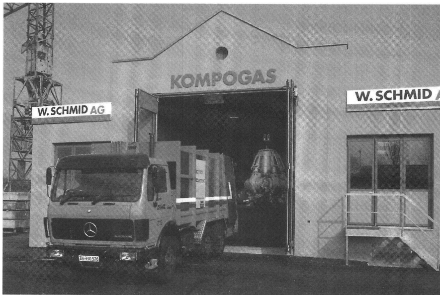
Abb. 5: Kompogasanlage in Rümlang.
