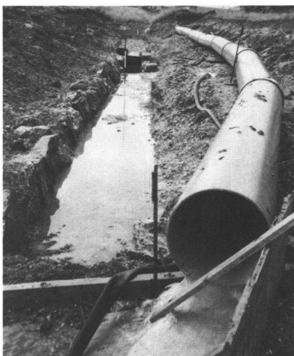
Gerinneausbau mit einseitigem Block-satz (Wasserhaltung während Bauausführung. Sommer 1982)
