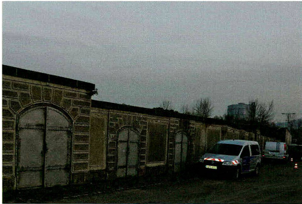
Überdeckte Langsamfilter von 1905.
