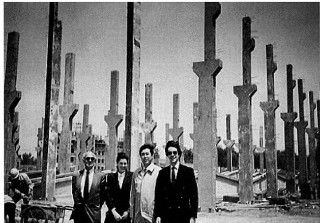
Bild 7: Bau Fabrik und Baufortschritt. (Foto: GF Agie Charmilles)
