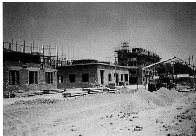
Bild 8: Bau Fabrik und Baufortschritt. (Foto: GF Agie Charmilles)
